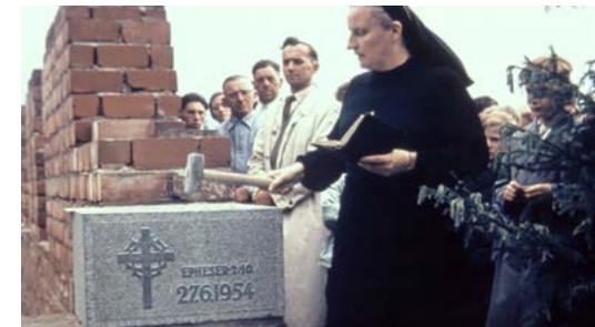
Grundsteinlegung - Hanna Hümmer
