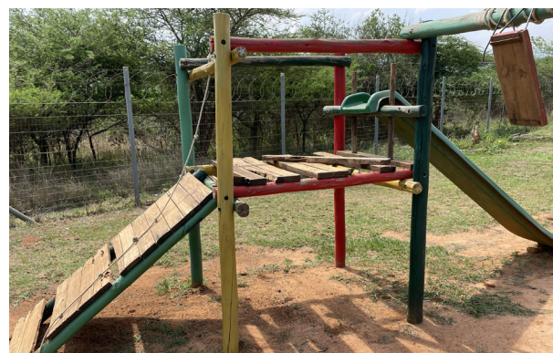
die kaputte Rutschbahn
