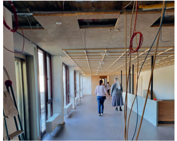
Zugang zu den Speisesälen
