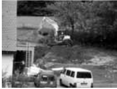
Anlegen des Hanges
