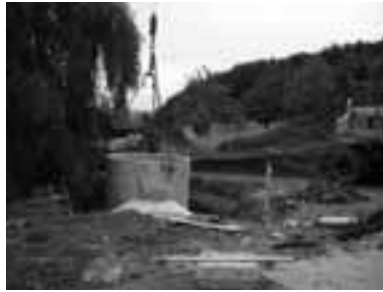
Einsetzen des Behälter für die Zisterne
